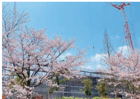
満開の桜と、建設中の新病院
