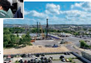
現在の建築工事現場の様子 (令和7年7月下旬撮影)
